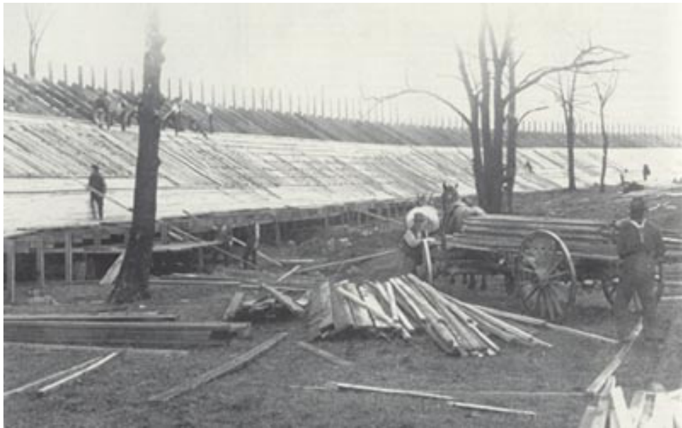
Motordrom under opførelse i Uniontown i Pennsylvania i 1916
